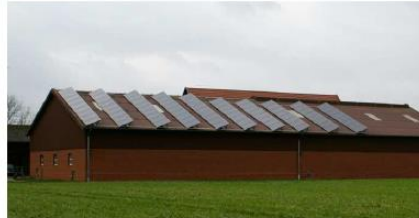
Aufgeständerte Solaranlage (> 20 cm)
