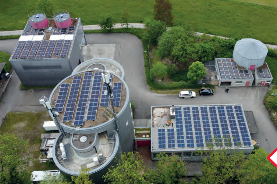
Auf den Dächern der ARA Münsingen wird Solarstrom produziert.
