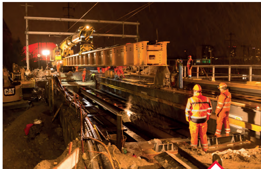
Einbau SBB-Hilfsbrücken
