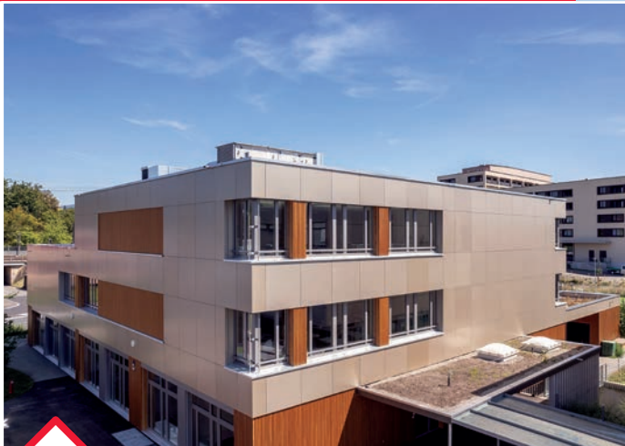
Westansicht Erweiterungsbau Prisma (Bild: Roman Burri)
