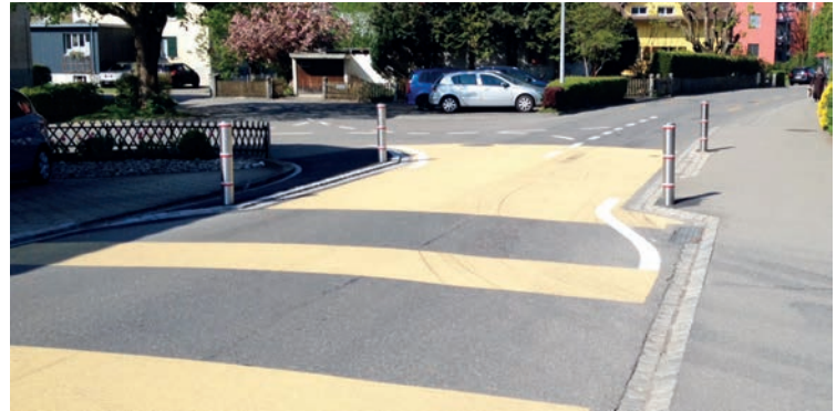
Geeignete Querungsstelle für Fussgänger/-innen
