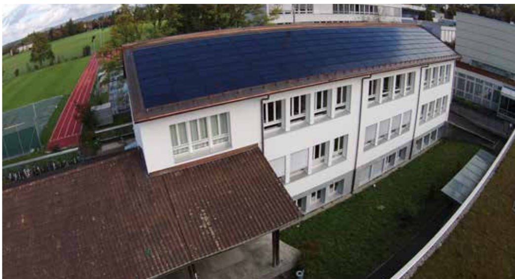
Photovoltaikanlage Schulhaus Schlossmatt Münsingen
