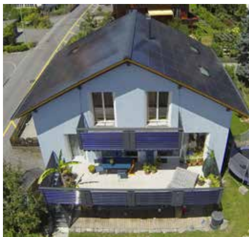
Luftbild eines Plus-Energie-Gebäudes (PEB). Dieses Gebäude wurde schrittweise innert sechs Jahren saniert. Es hat neu eine Fotovoltaikanlage, eine thermische Solaranlage und eine gute Aussenisolation. Auf eine Komfortlüftung wurde bewusst verzichtet.
