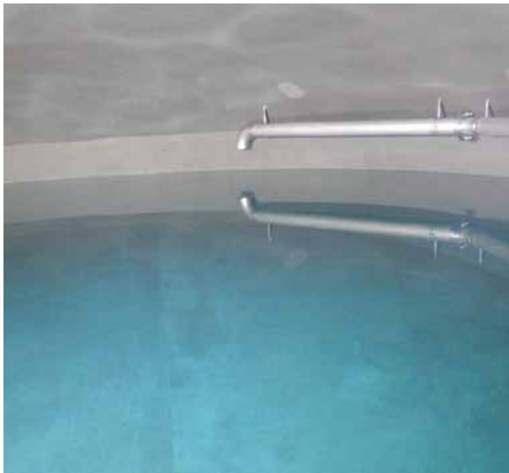
Blick in den sanierten Wasserbehälter im Reservoir Buchli
