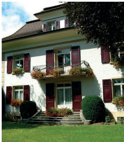
Ort der Sprechstunde: Büro Gemeindepräsident, Verwaltungsgebäude, Neue Bahnhofstrasse 4, 3110 Münsingen
