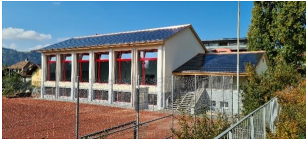
Turnhalle II mit Photovoltaikanlage
