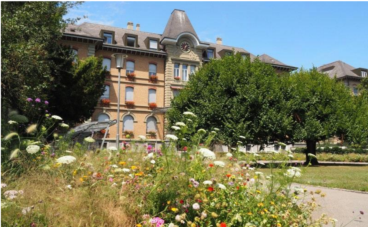
Abb. 6 Aussenraum beim Psychiatriezentrum Münsingen Quelle: PZM AG
