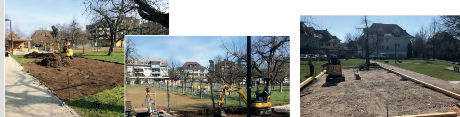
Bau des neuen Boule-Platzes in fünf Arbeitstagen
