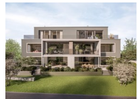
Überbauung «Zwischen den Giessen», Belpbergstrasse (im Bau)
