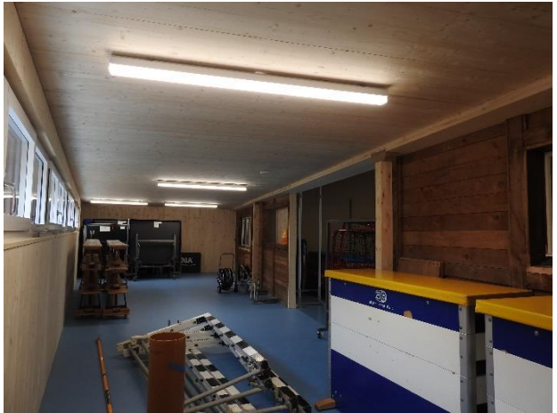
Materialraum im Anbau
