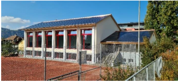
Turnhalle II mit Photovoltaikanlage
