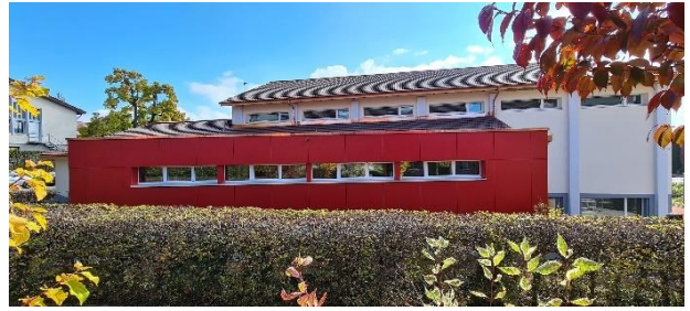
Turnhalle II mit Anbau
