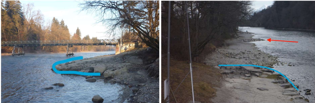
Abbildung 8: Unterer Teil des Schutzsystems in Fließrichtung (links, Aufnahme vom 12.01.22) und oberer Teil gegen die Fließrichtung (rechts, Aufnahme vom 24.02.22). Die Bühne ist auf dem rechten Bild mit einem roten Pfeil markiert.
