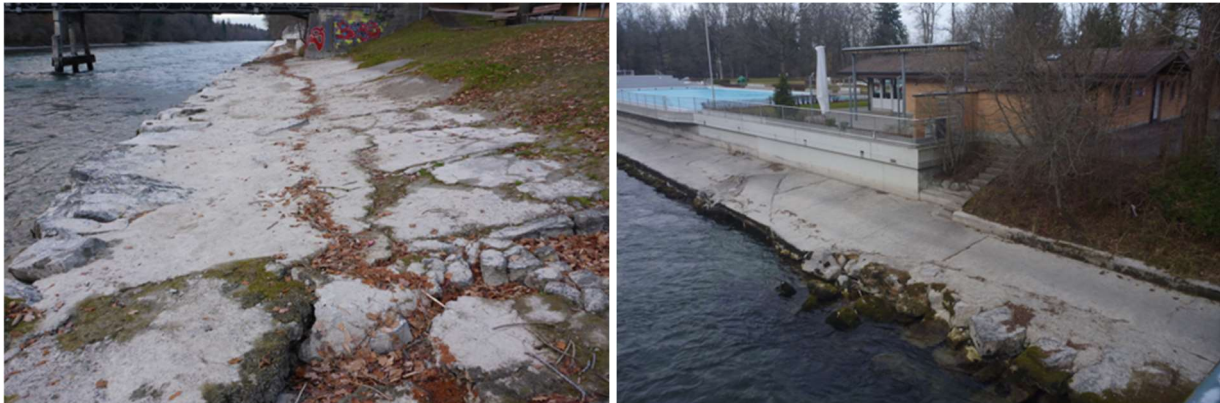
Abbildung 9: Betonplatte mit wasserseitiger Blockreihe (links, Blick in Fließrichtung, Aufnahme vom 23.11.17), Übergang zum Uferverbau entlang der Badi (rechts, Aufnahme vom 24.02.22)
