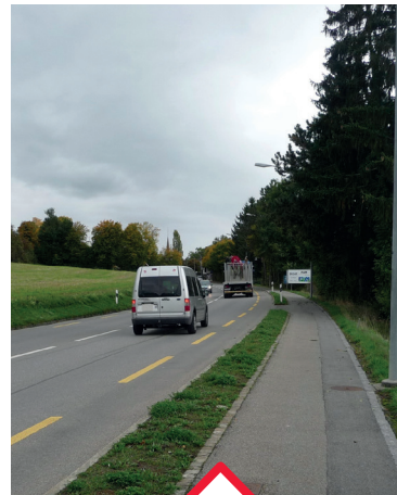
Baubeginn Dorfszentrum und Entlastungsstrasse Nord
