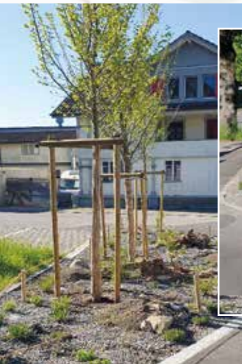
Entsiegelungen und Baumpflanzungen im Bereich Thunstrasse / Bahnhofstrasse
