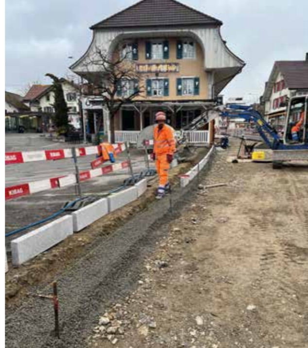
Die Sanierung der Thunstrasse schreitet gut voran. Anfang Juni 2025 kann der Deckbelag eingebaut werden.
