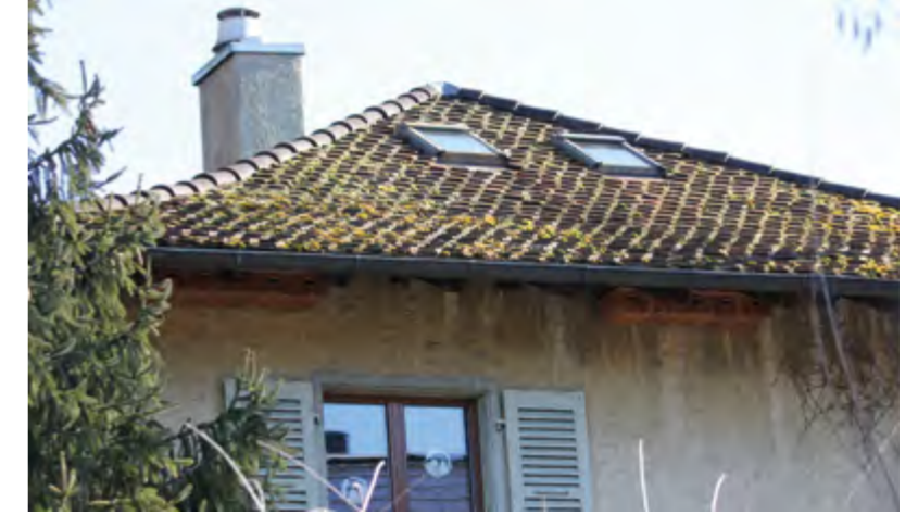
Mauerseglerkästen an der Tagesschule Sonnhalde ©Simone Sikyr
