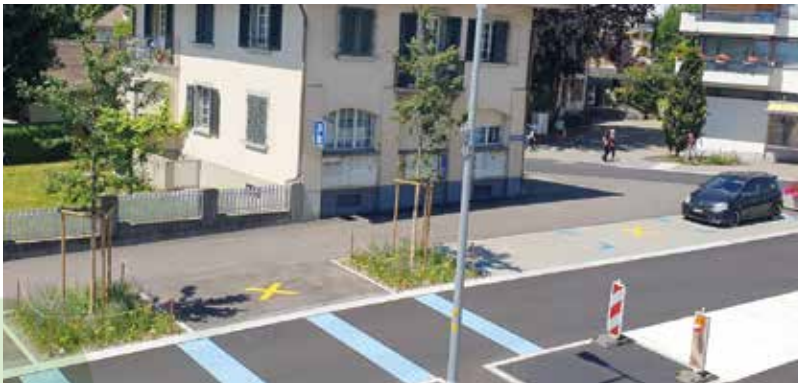
Baumpflanzungen und wasserdurchlässiger Belag bei Parkplätzen an der Thunstrasse
