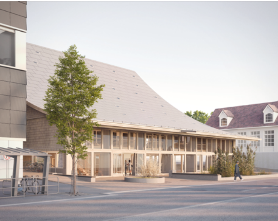
Blick auf die Westseite des Gebäudes vom Bahnhof her.
