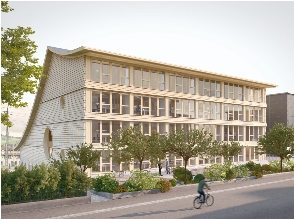
Blick auf die Ostseite des Gebäudes vom Kreuzweg her.
