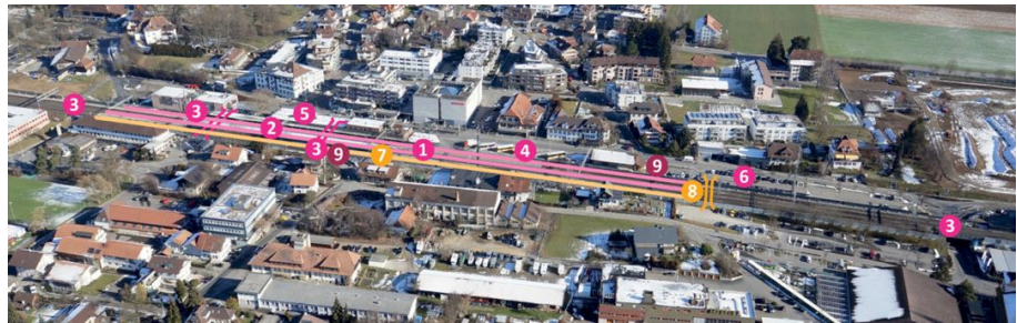
Abbildung 5: Ausbau Bahnhof Münsingen.
