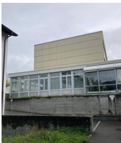
Abbildung 5 Abgrabung West-Seite nördliche Ecke Bestand
