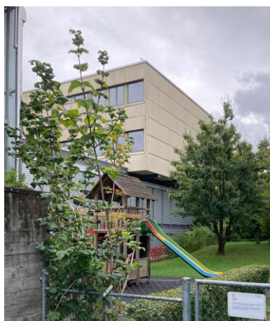
Abbildung 6 Abgrabung West-Seite südliche Ecke Bestand
