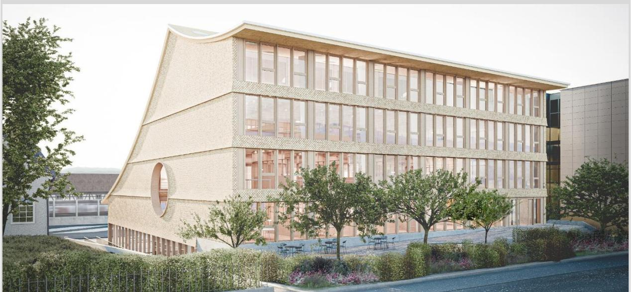
Abbildung 2: Fassadenansicht Südost, Blick von Kreuzweg. Die Ost-Fensterflächen bringen viel Licht in die Bürofläche. Die Gestaltung der Südfassade verhindert eine Überhitzung des Gebäudes im Sommer. (Referenzbild, Änderungen im weiteren Projektverlauf sind möglich.)
