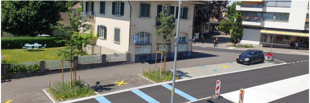
Beispiel neue Bäume an der Thunstrasse mit Begrünung der Standfläche
