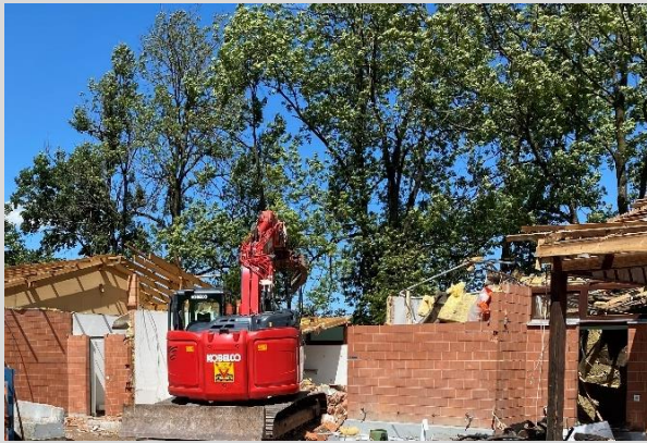
Abbrucharbeiten am alten Garderobengebäude
