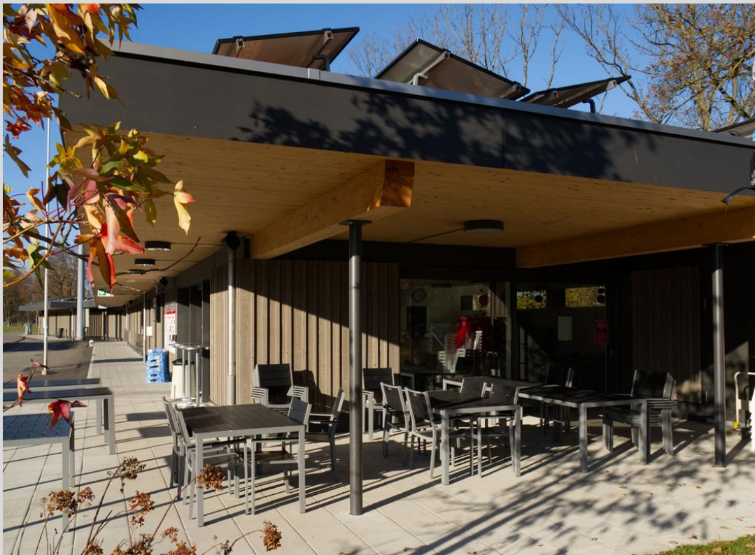
Neues Garderobengebäude (Ansicht Eingang Buvette)
