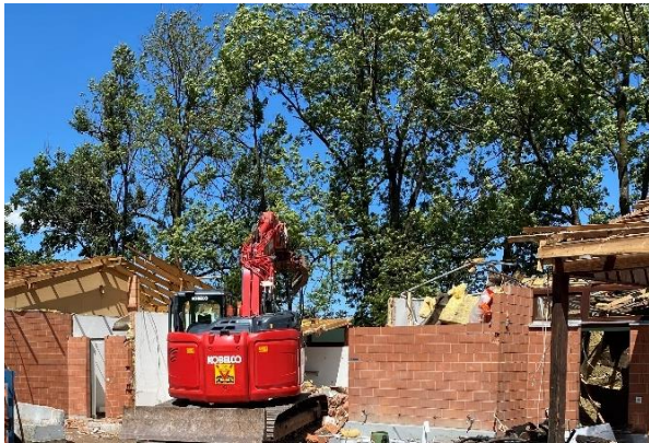
Abbrucharbeiten am alten Garderobengebäude
