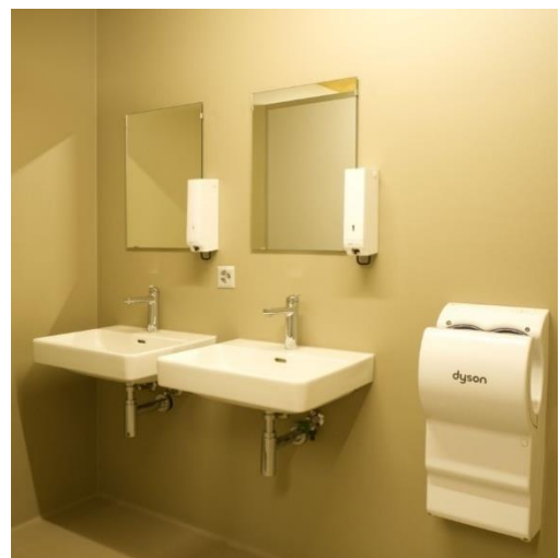
Waschbecken im Garderobengebäude
