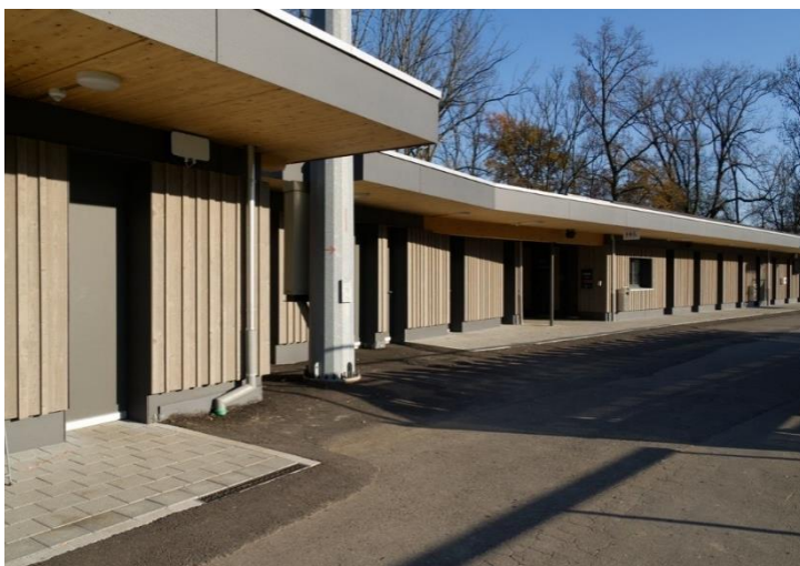
Neues Garderobengebäude (Fassadenansicht)
