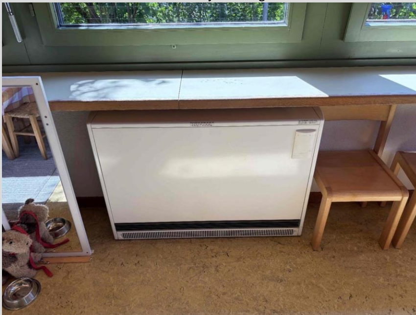
Abbildung 1: aktuell verbaute Elektrospeicheröfen und zu ersetzender Boden UG
