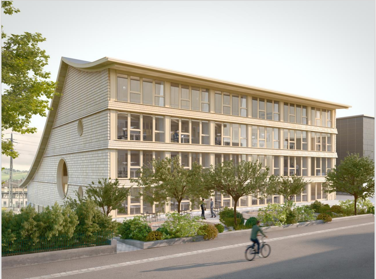
Abbildung 2: Fassadenansicht Südost, Blick von Kreuzweg. Die Ost-Fensterflächen bringen viel Licht in die Bürofläche. Die Gestaltung der Südfassade verhindert eine Überhitzung des Gebäudes im Sommer. (Referenzbild, Änderungen im weiteren Projektverlauf sind möglich.)
