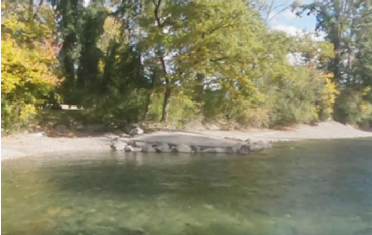
Abbildung 6: Buhne im Oberlauf des Projektperimeters, Quelle: Google Street View
