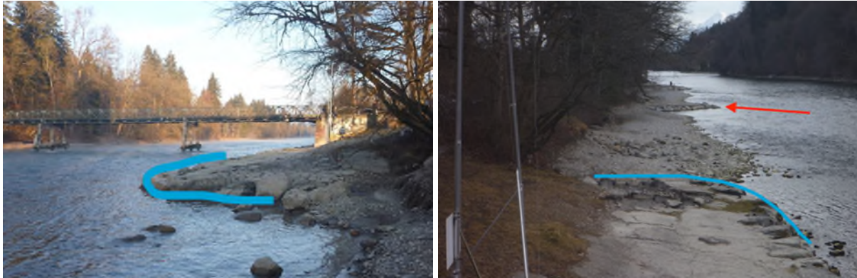
Abbildung 8: Unterer Teil des Schutzsystems in Fließrichtung (links, Aufnahme vom 12.01.22) und oberer Teil gegen die Fließrichtung (rechts, Aufnahme vom 24.02.22). Die Buhne ist auf dem rechten Bild mit einem roten Pfeil markiert.
