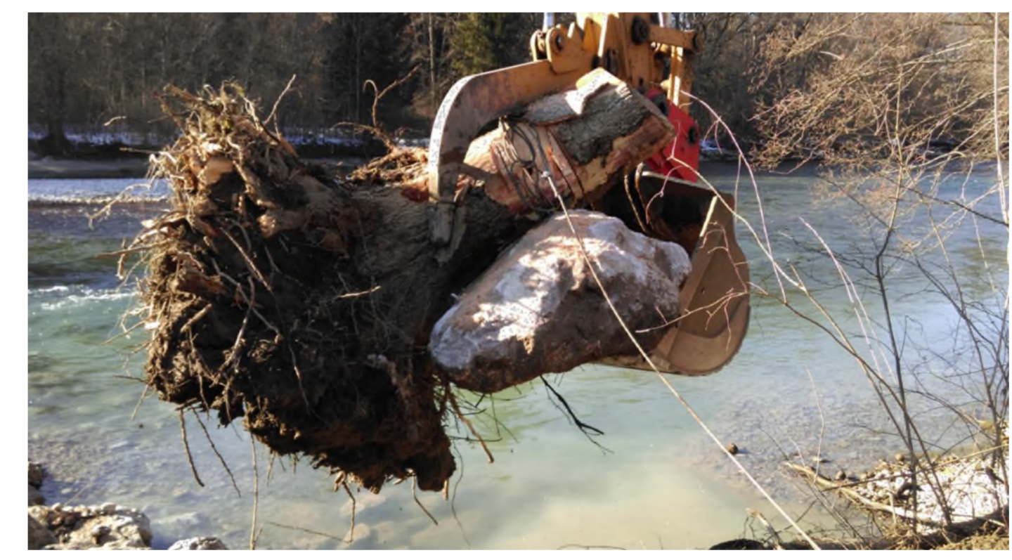
Beispiel eines verankerten Wurzelstock (Aare Hunzigenau, Gemeinde Rubigen)
