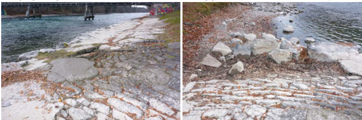
Abbildung 7: Pflasterung im Übergang zwischen dem geschützten und ungeschützten Ufer (links Blick in Fließrichtung, rechts gegen Fließrichtung)
