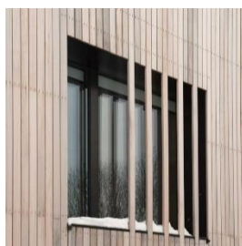
Fenster | Holzlamellen als Vogelschutz und Gestaltungselement
