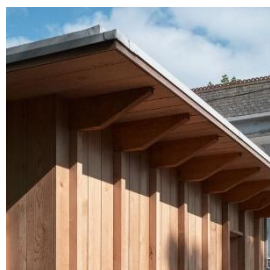
Vordach | Sichtbare auskragende Holzkonstruktion
