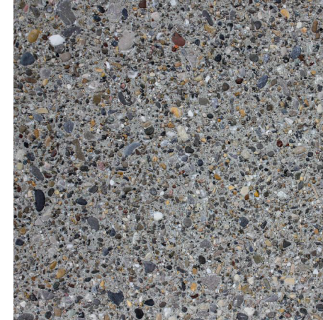
Bodenbelag Best. Plattenboden reinigen und behandeln
